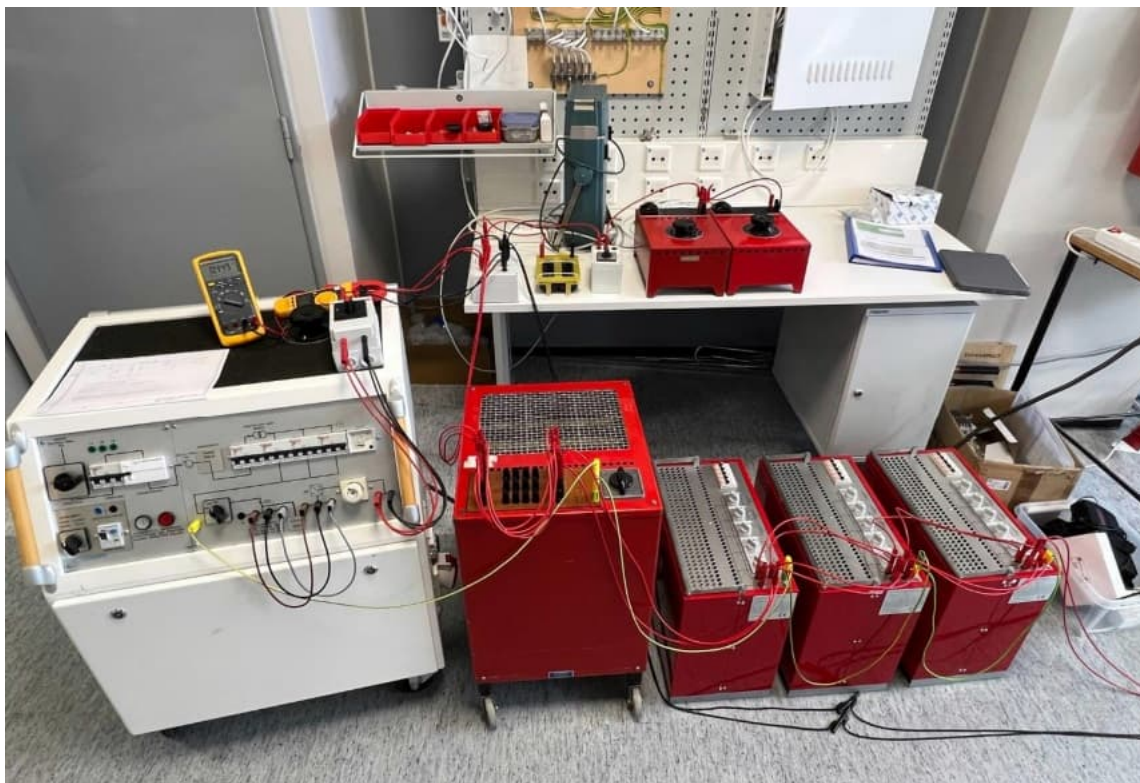
KUVA 27. TAMKin sähkövoimatekniikan laboratorioon toteutetun aurinkosähkösimulaattorin komponentit.
