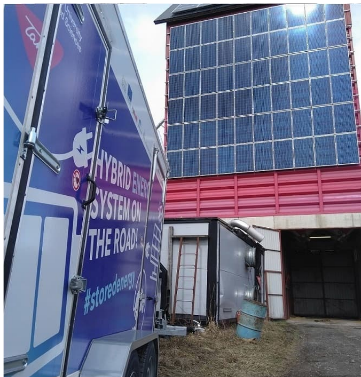
KUVA 23. Demonstraatio heikon sähköverkon tukemisesta älykkään tehonhallinnan energiavaraston, ja uusiutuvan omatuotannon avulla keväällä 2021.
