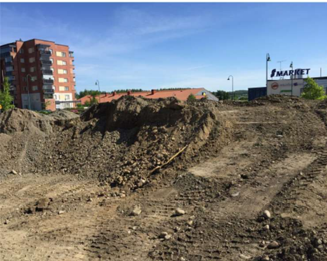
7. Työmaalta kaivettua kynnysarvomaata toimitettiin väliaikaiseen läjitykseen naapuritontille 0
