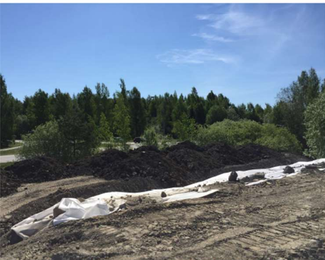
8. Työmaalta kaivettua kynnysarvomaata läjitettiin Halkolannotkoon meluvallin sisärankenteek:
