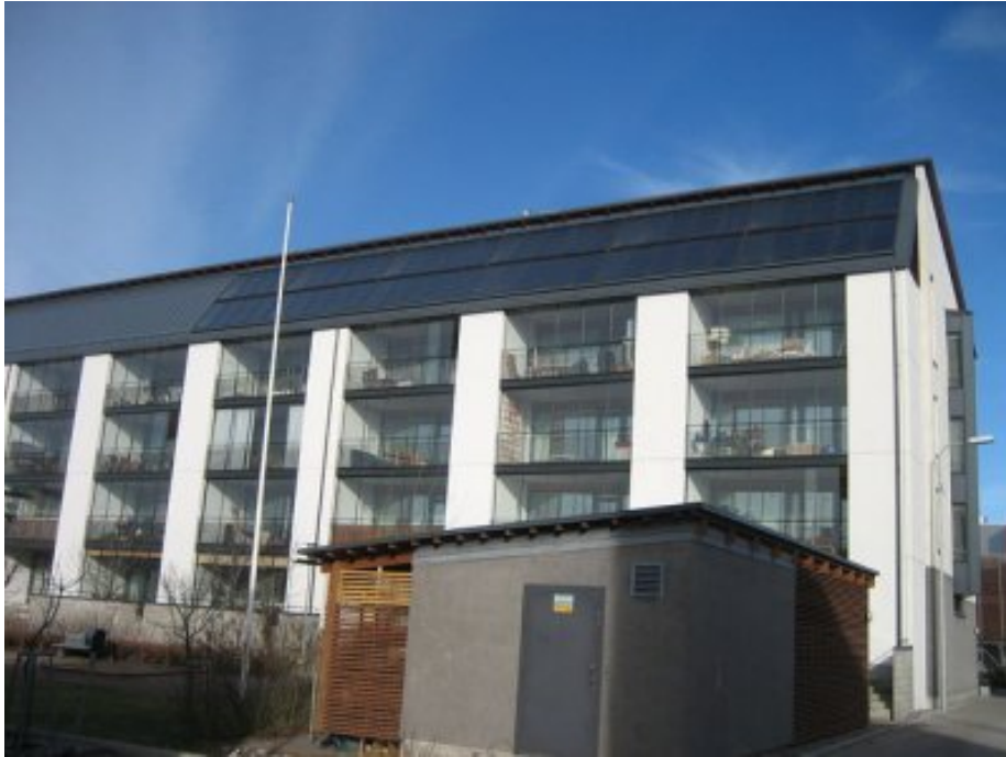
KUVA 8. Sonnenkraft aurinkolämpöjärjestelmä Helsingin Ekoviikissä. ( http://www.aurinkovoima.fi/fi/tuotteet/sonnenkraft-tuotteet )
