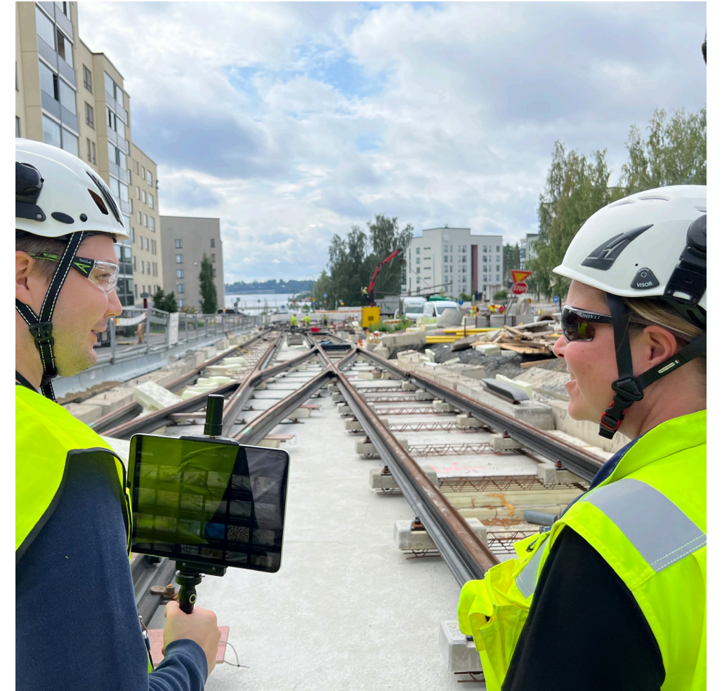
Raitiotietyömaan dokumentointia Lentävänniemessä
