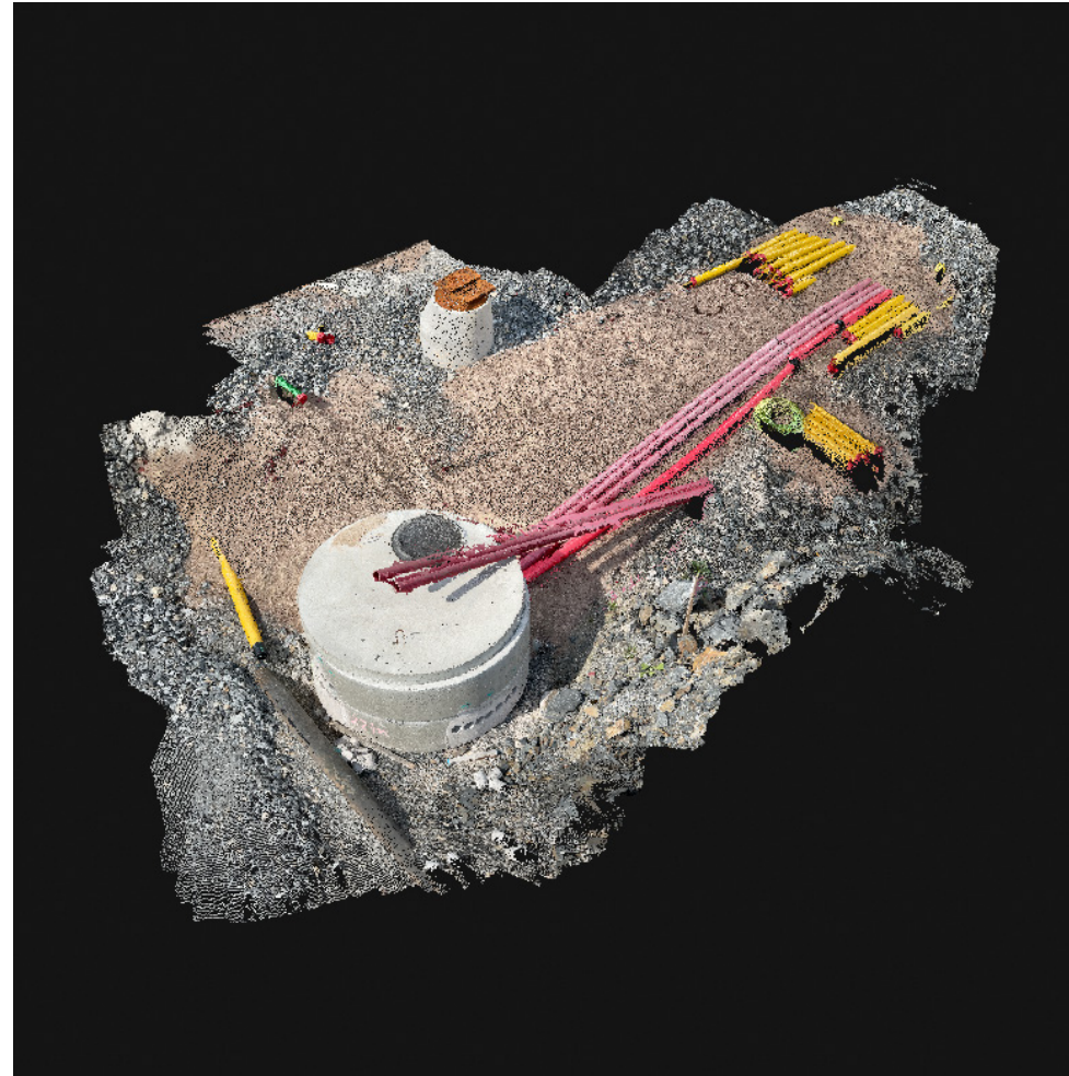
Raitiotietyömaan rakenteiden pistepilviaineistoa
