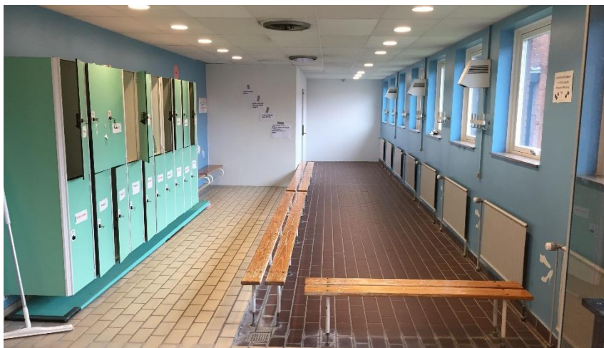
Figur 17: Det ene af de to omklædningsrum der skal ombygges
