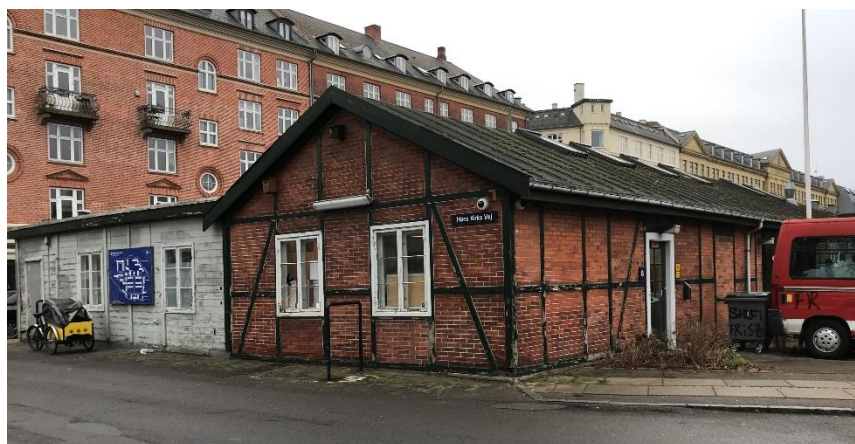
Figur 6: Maskinhuset som skal nedrives selektivt i forbindelse med opførelsen af Center for Diabetes. Set fra Hans Kirks Vej.
