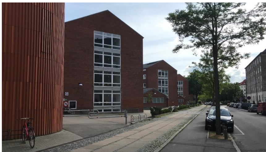
Figur 11: De tre bygninger på Sjællandsgade 38-42 som skal selektivt nedrives.
